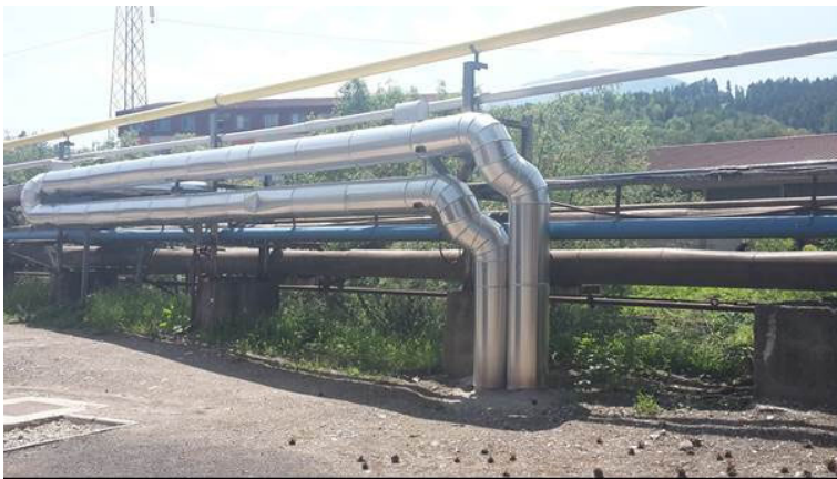
Slika 2: UHP peč, distribucijski vodi in postroji za koristno izrabo odvečne toplote UHP
